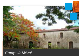
Grange de Méaré
